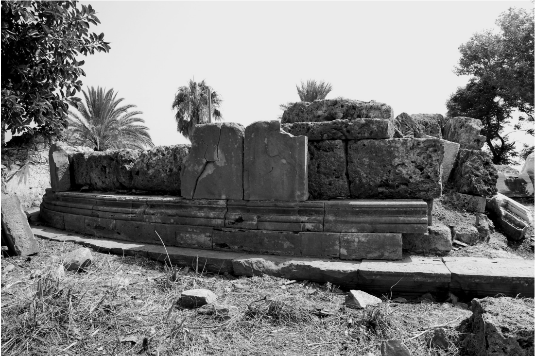
Res. 4 Üst katta cella nın günümüze korunarak gelen kuzey batı köşesinin yükselen duvarı: Dış duvarların: Dış tarafı gri renkli kumtaşından oluşan orthostat plakalarla kaplanmıştır, asıl taşıyıcı çekirdeği ise traverten bloklar oluşturmaktadır (Foto: J. S. Heinz).
